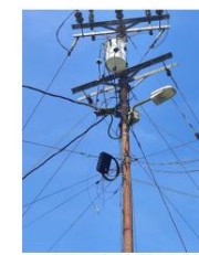
Figura 4. Transformador de la comunidad
